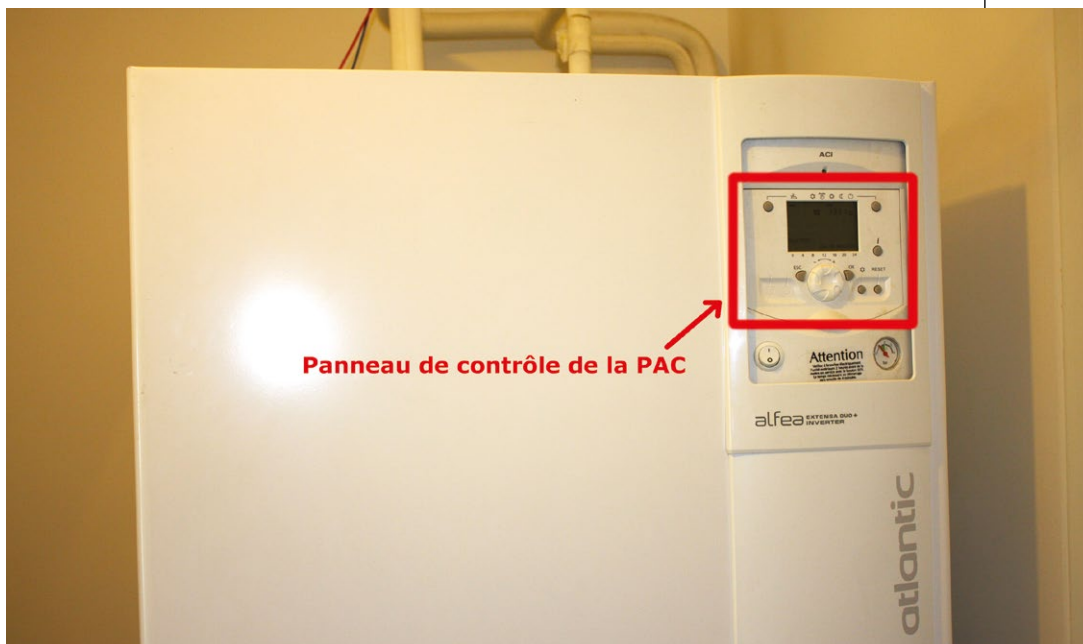
Figure 1 : Module intérieur de la pompe à chaleur Atlantic Alfea Extensa Duo+ sur lequel on distingue le panneau de contrôle en haut à droite.
